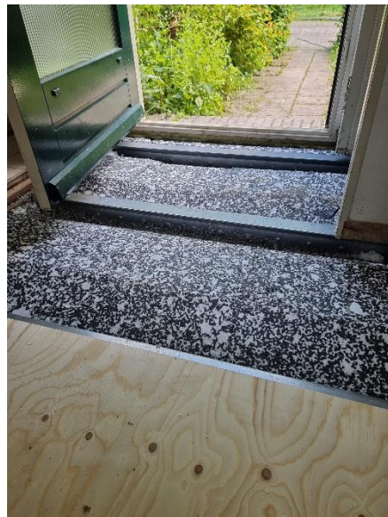
De isolatie'broodjes' die onder de nieuwe vloer zijn geplaatst
